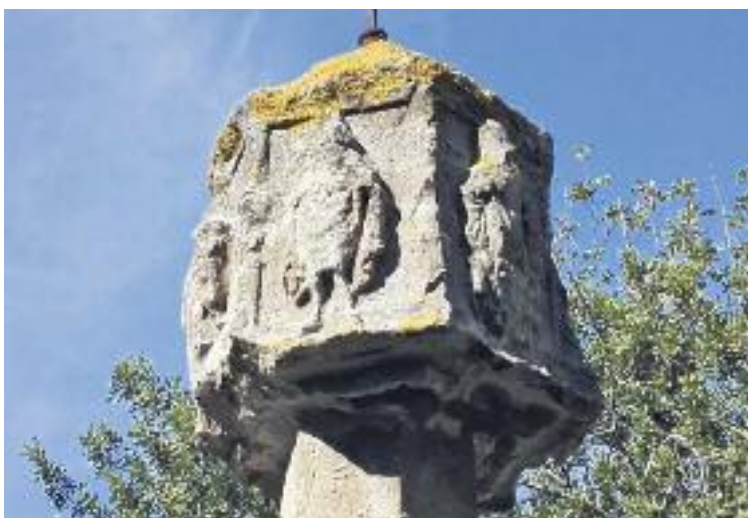
La magolla (també coneguda com llanterna o edicle) té forma hexagonal, amb uns baix-relleus molt acurats, si bé deteriorats i de difícil identificació
