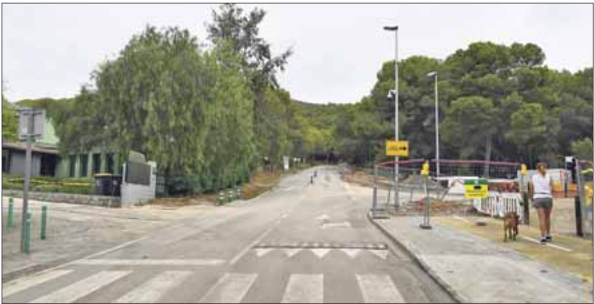
El punto donde se construye la rotonda, en la carretera de la Sentiu con la calle Lola Anglada, fotografiado a mediados del mes pasado
