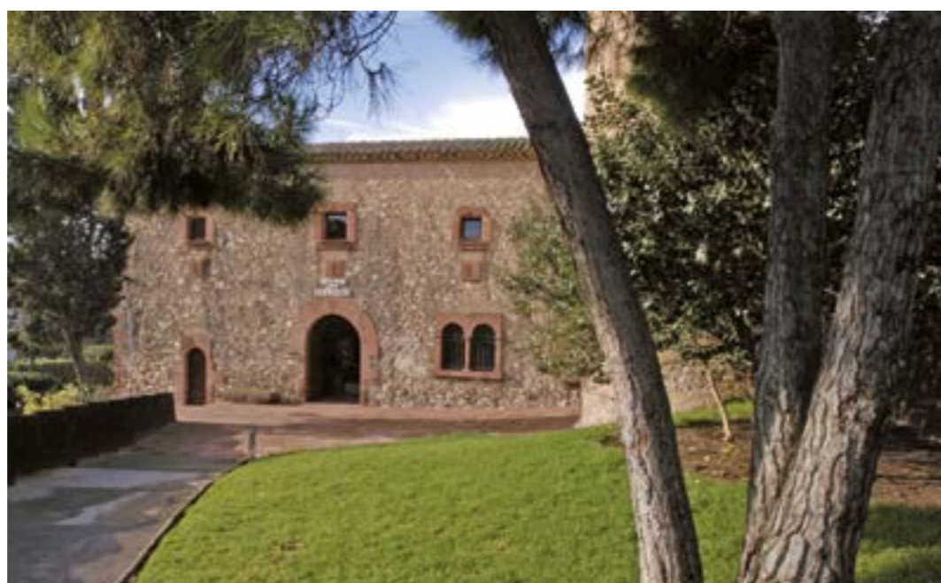
La reforma es du a terme tenint en compte la preservació dels elements estructurals d'interès històric
