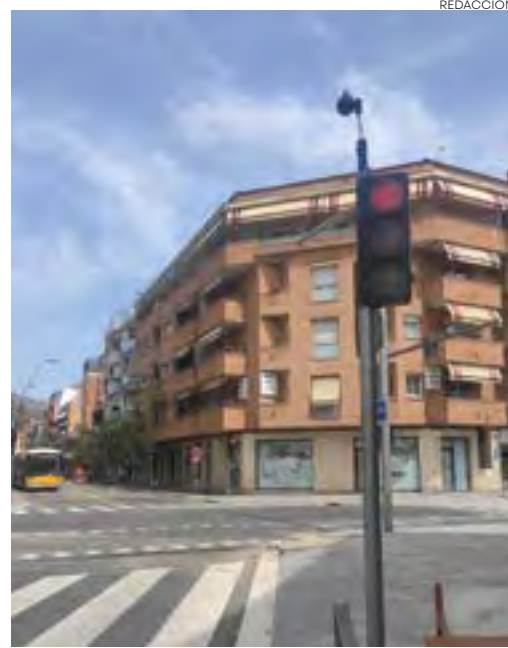
Semáforo instalado en el cruce con la av. de la Pineda
