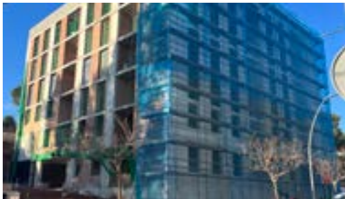
Obres de construcció dels habitatges del c/Pietat
