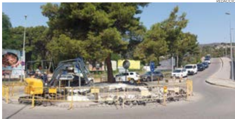
Estat actual de la rotonda de l'avinguda de la Platja amb l'avinguda Pitort
