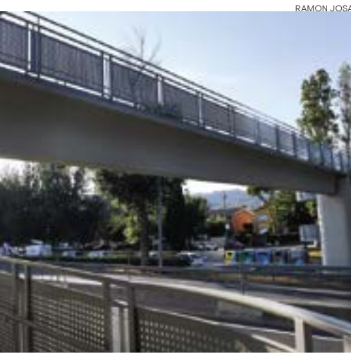
Uno de los pasos donde se han realizado trabajos de mejora
