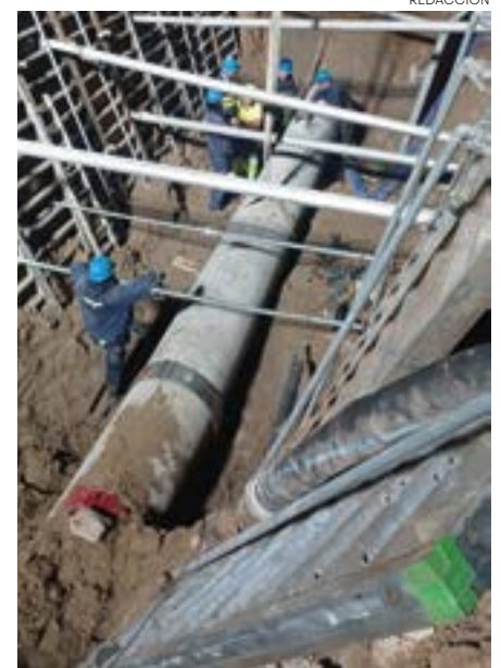
Operarios trabajando en la sustitución del colector dañado
