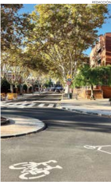
Un tramo de la avenida de la Pineda ha recuperado la doble dirección para vehículos
