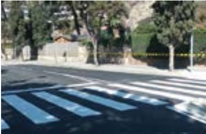
Mejoras de aceras y renovación de asfaltado en general
