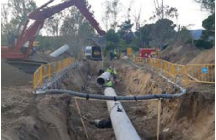
Estación de bombeo de agua en terrenos de Gran Via Mar
