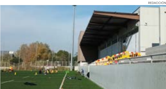
El estadio de Pitort cuenta con una nueva marquesina que da sombra a la grada
