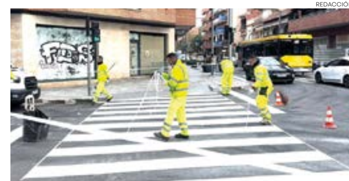
Trabajos de asfaltado en la calle Dr. Ferran
