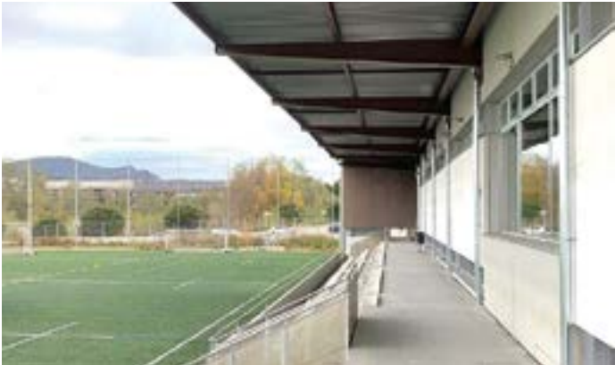
La nueva marquesina del estadio de Pitort
