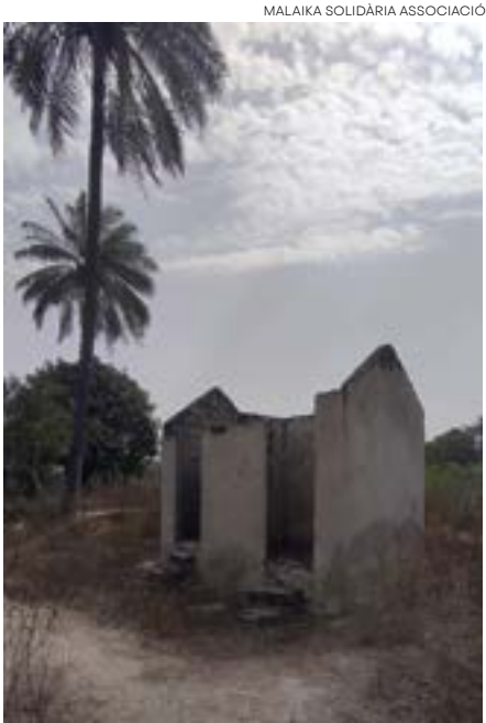
Fases de l'edifici de vàters ara. Escola Medina de Talokoto (Gàmbia)
