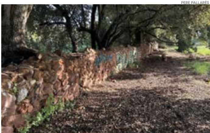
El mur de contenció de la riera dels Canyars
