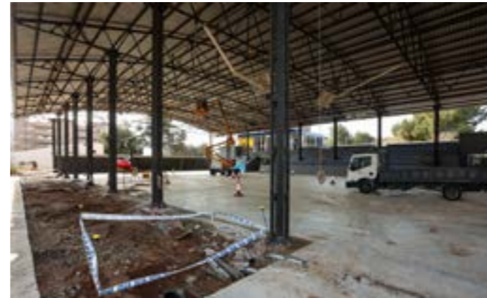
Treballs de desballestament de l'actual coberta de la pista de Can Roca
