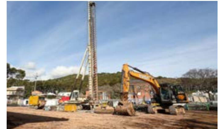
Les màquines ja treballen en la construcció del nou pavelló de Can Vinader
