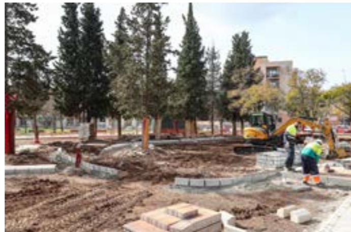
Els operaris fa setmanes que treballen en la renovació del parc dels Xiprers
