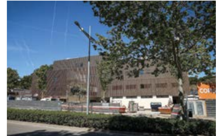
La construcció de l'edifici, en uns terrenys cedits per l'Ajuntament al barri de la Muntanyeta, ja està pràcticament acabada
