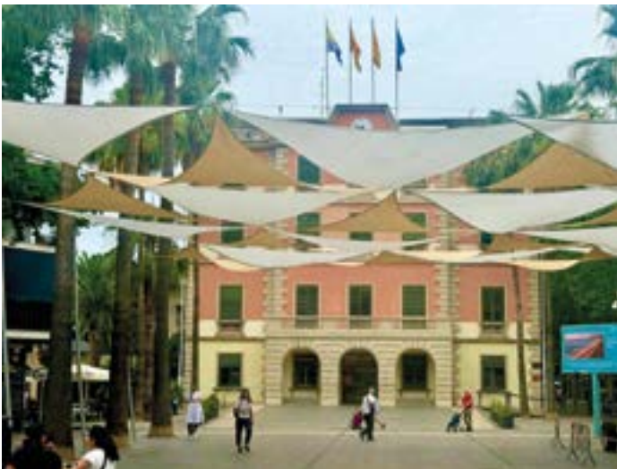
Estructura de sombreado en la plaza de la Iglesia
