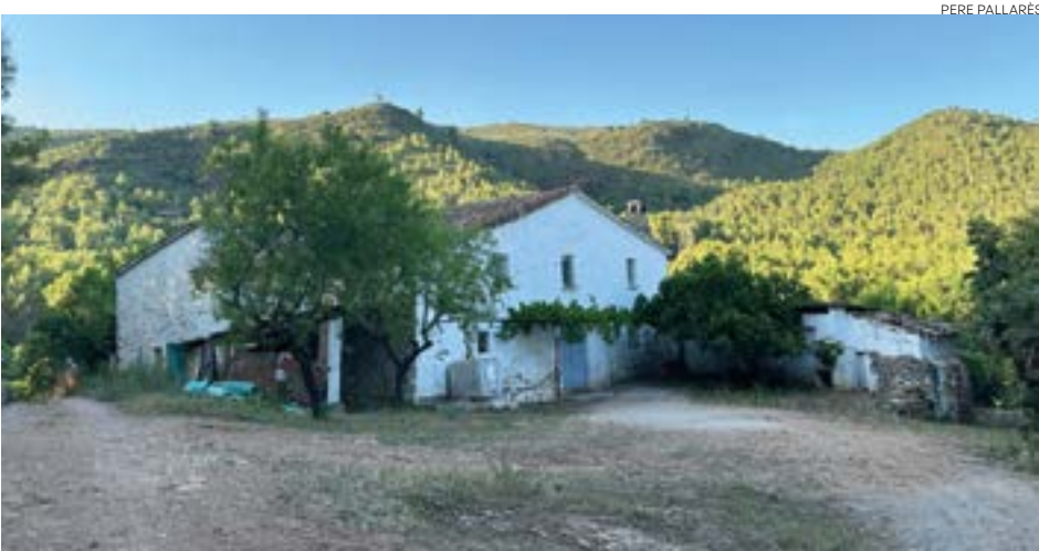
La Can Pardal original situada a la vall de la Sentiu de Gavà
