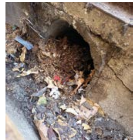
En el operativo también se limpian las salidas de aguas pluviales
