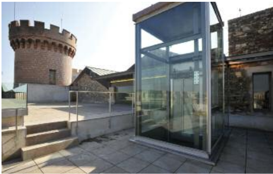
/ El nou ascensor va fins a la terrassa mirador del Castell /
