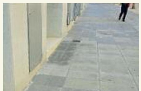
El asentamiento de edificios y el paso de vehículos por una zona destinada a los peatones ha ido afectando los distintos pavimentos de este tramo. Ha sido necesario sanear la base y reponer losas, en una superficie de 225 m<sup>2</sup>, con un coste de 19.000 €.
