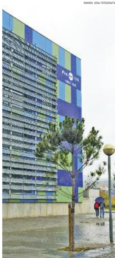
L'edifici RDIT, al campus de Castelldefels
