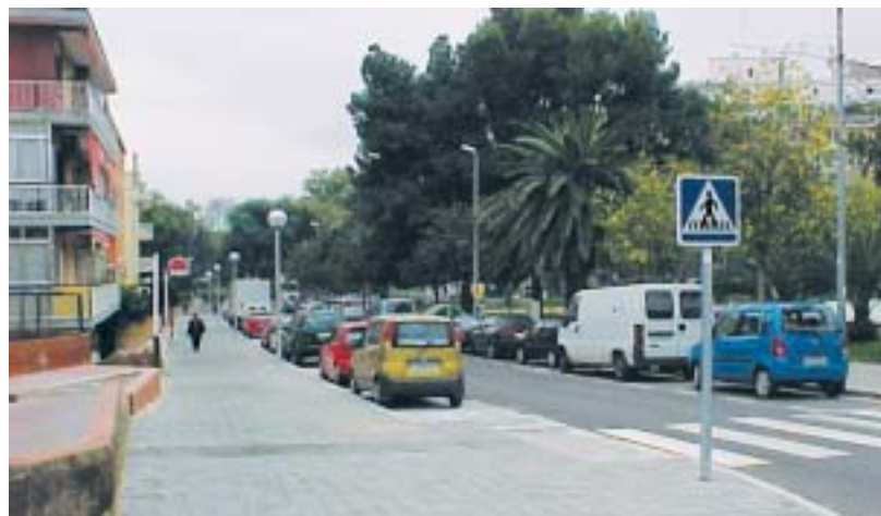
A l'esquerra, imatge del carrer Dr Marañón abans de l'actuació. A la dreta, estat final acabats els treballs
