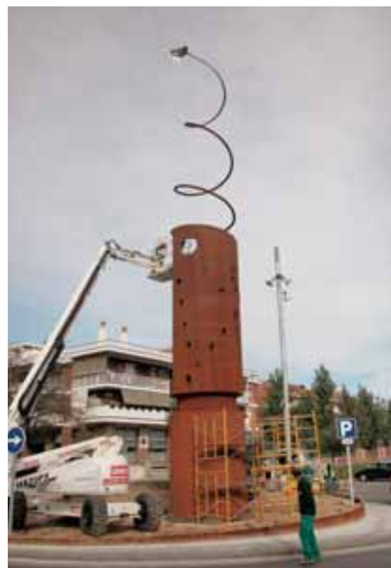
Moment en què s'enllestí la instal·lació de la peça
