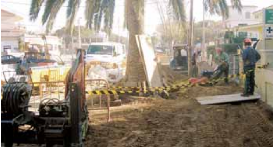
Operaris treballen en la remodelació d'un tram de vorera al passeig Marítim de Castelldefels
