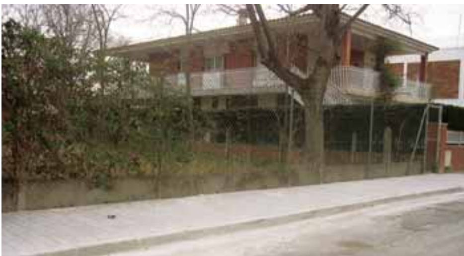
Una de les actuacions realitzades, al barri de Gran Via Mar
