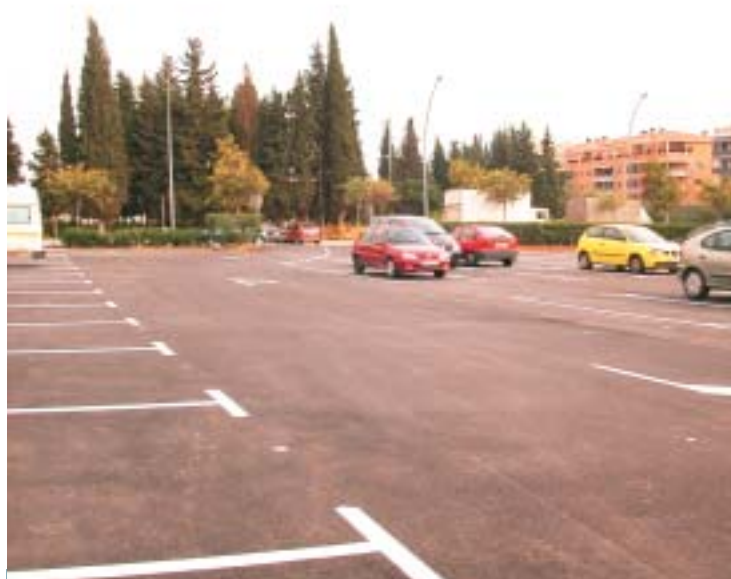
Continuen asfaltant-se diferents punts de la ciutat, com aquest nou aparcament a Otero Pedrayo
