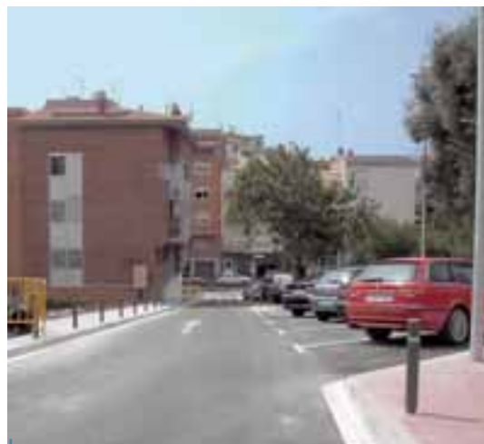
El tramo de conexión ya es circulable
