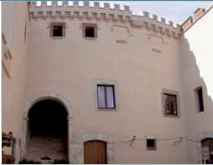
El pati també serà rehabilitat en aquesta fase de les obres
