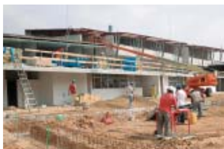
Trabajos en la fachada interior y la zona de recreo, a finales del mes de junio
