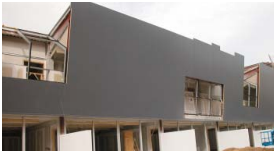
Una de las fachadas del edificio más avanzado, que acogerá a los alumnos de P-3, P-4 y, P-5
