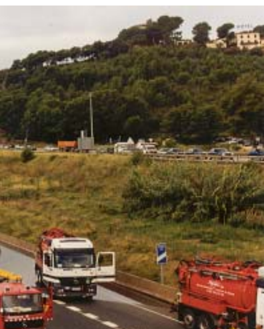
En la autopista, hubo inundaciones en la rotonda de Ca n'Aimeric
