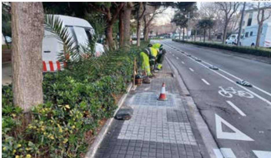
Trabajos de reparación de la acera en la avenida de Málaga
