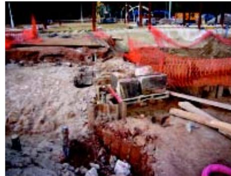
Todo dispuesto para desmontar el resto de los sillares de las aristas del puente, debidamente numerados.
