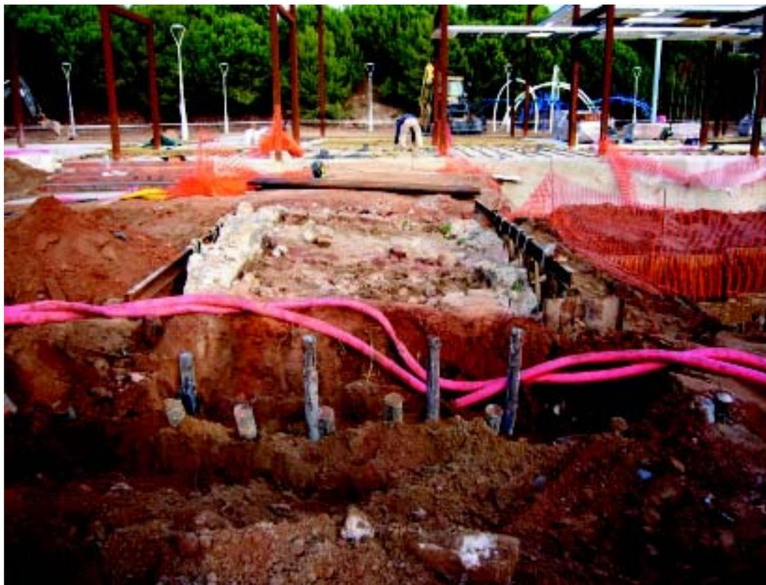
Extracción ordenada de los elementos labrados que conforman la arista del arco; labor realizada el 7 de diciembre de 2009.
