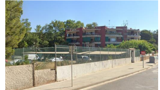
Zones d'aparcament, al PG del Ferrocarril 11-13
