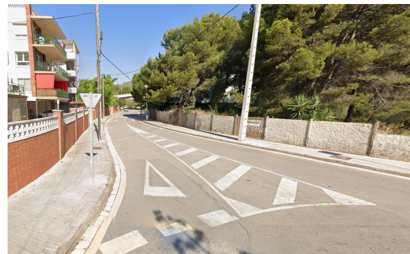
Passeig del Ferrocarril en el tram de la modificació
